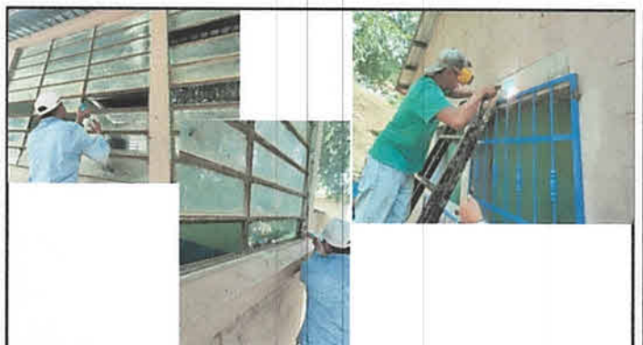
Foto 4: Desmontaje de vidrios quebrados y reposición. Más instalación de balcones de metal.
