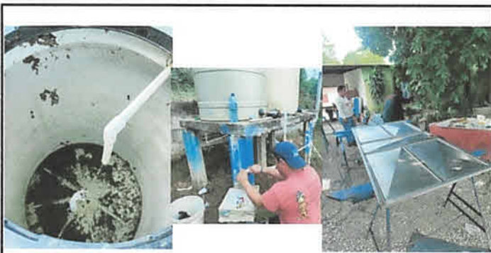
Foto 5: Limpieza de tinacos, instalaciones hidráulicas, la colocación de flotes y tapaderas en tinacos. También la elaboración de dos puertas de metal.
