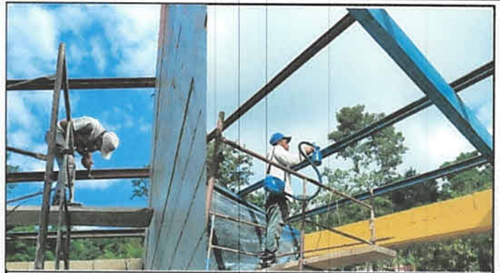
Foto 2: Lijado y pintado de estructura.
