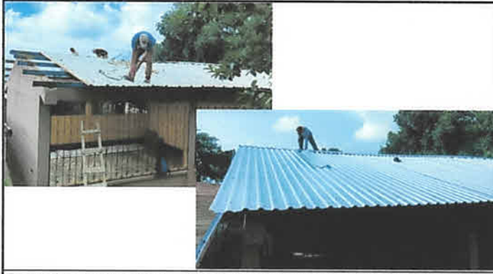
Foto1: Desmontaje de lámina y capote dañados e instalación de lamina troquelada y capote nuevo.
